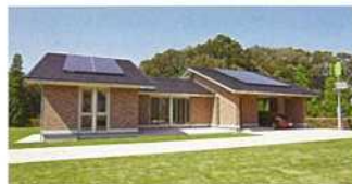
■スマートハウス実習棟(八王子校)
