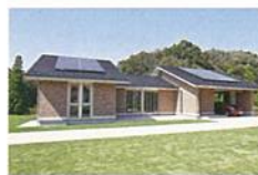
スマートハウス実習棟(八王子校)
